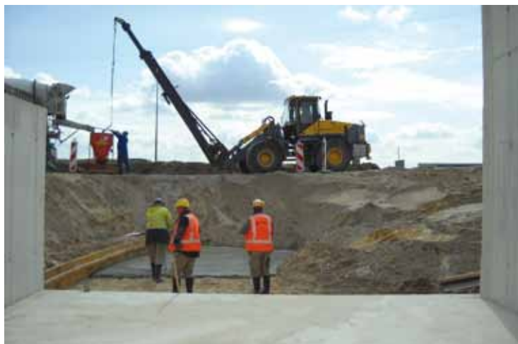
◀ Typisch Nederlandse oplossing: beton storten met de wiellader dankzij een mast waar de forse kubel aan kan hangen.
