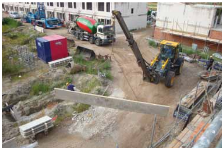
◀ Vloerplaten in een tweesprong kun je met de wiellader gemakkelijk op de eerste of tweede verdieping leggen. Daar hoeft geen telescoopkraan voor te komen.
